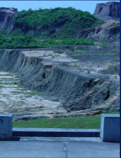
除计划保留用作 **建库遗迹** 的一块高土台外，整个取土场已经基本整平，并覆盖表土、种草植树，道路两侧修筑排水沟。尽管今年雨水较多，但没有明显的冲刷痕迹，也无地表下陷和坍塌。
